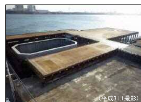
② 橋脚MP4(平成30.12施工完了) ニューマチックケーソン基礎完成
