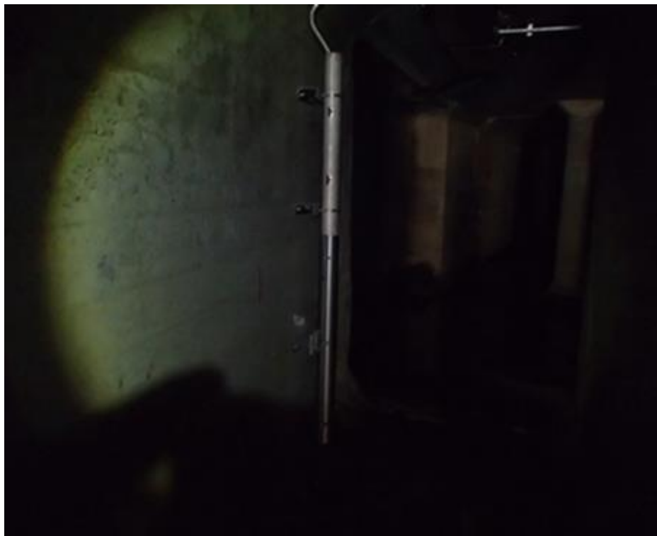
内水位計（管きよ内水位）
