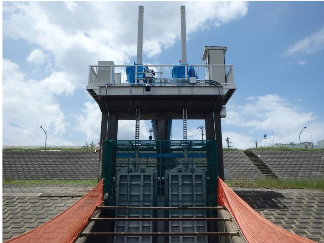
(2) 宮内排水樋管ゲート (フラップ機構付ゲート)
