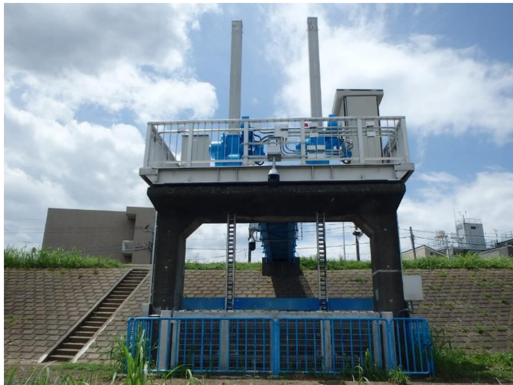
(3) 諏訪排水樋管ゲート
