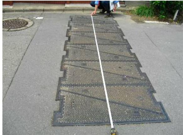
ポンプ投入口（鉄蓋寸法・蓋開口時有効寸法）：角落し室①に設置の場合
