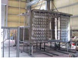
客室後部製作 令和2年10月中旬
