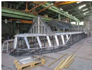
船体部材製作 令和2年9月下旬
