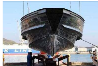
本体構造完成反転完了 令和2年11月下旬
