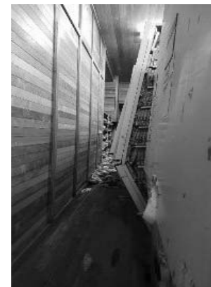
第6収蔵庫内部 (10/23)
