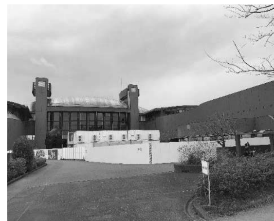
施設前広場の仮囲い
