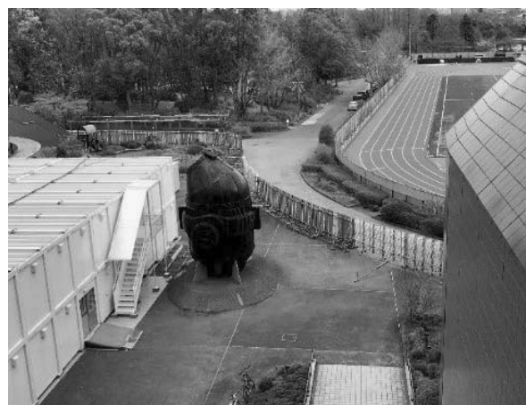
施設前広場の仮囲い（上部から撮影）
