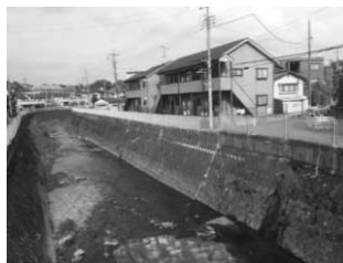
整備後の平瀬川
