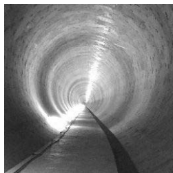
五反田川放水路
