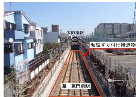
仮設すり付け箇所
