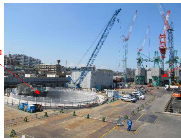
工事の様子(令和3年4月)
