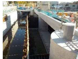
分流部施工状況
