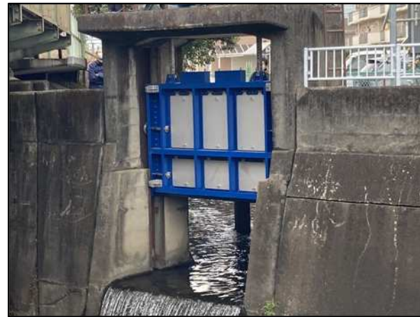
大丸水門の改修
