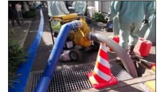
移動式ポンプ機
