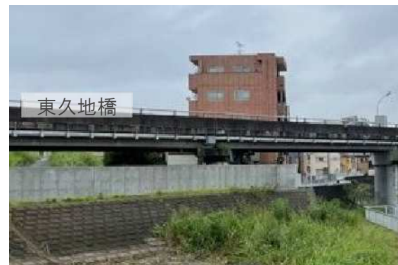
擁壁の設置状況
