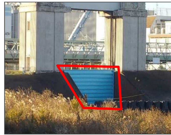
止水壁（水門前面）
