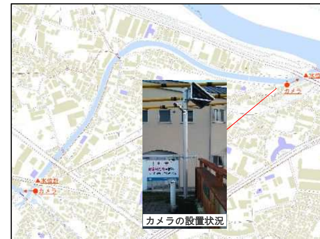
水位計・カメラ設置位置
