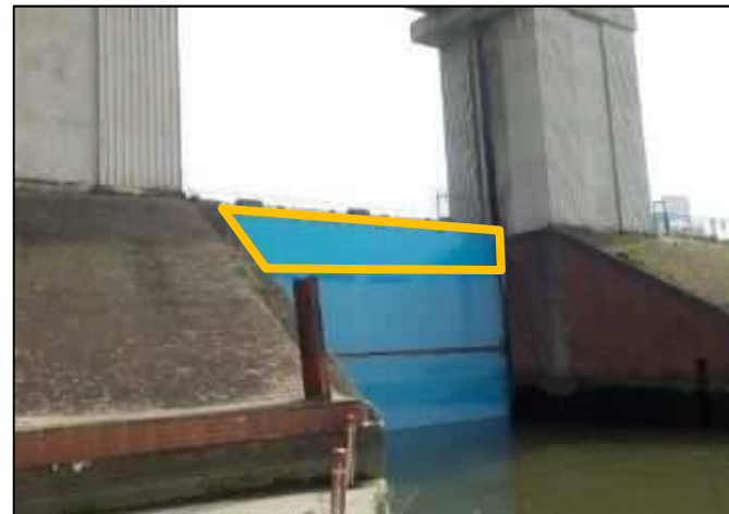
既設扉体嵩上げ
