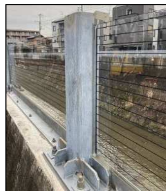
亚克力板の補修
