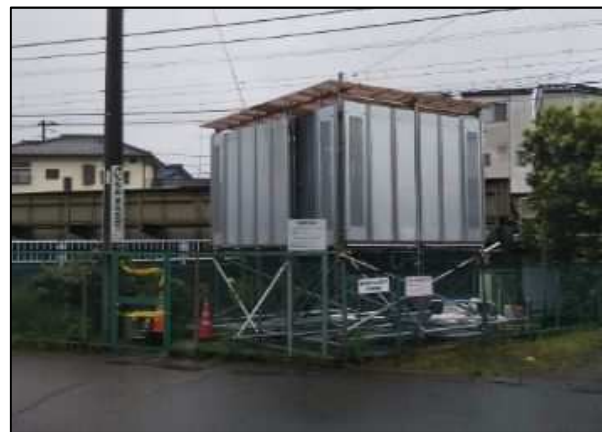
大丸用水接続部のポンプ倉庫
