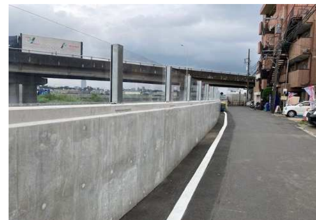
アクリル板の設置状況
