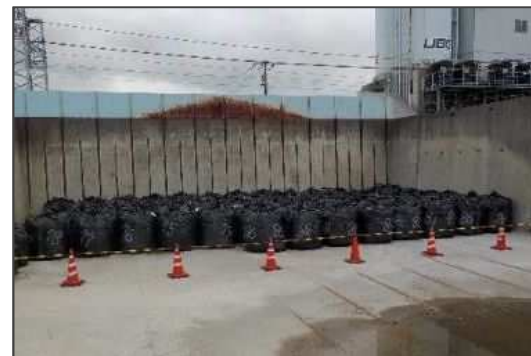
配備した大型土のう
