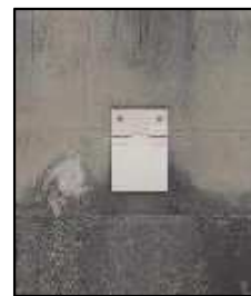
フラップゲート設置
