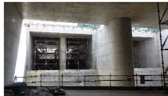
②導水路施工状況
