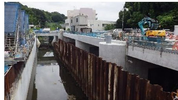
①分流部施設施工状況
