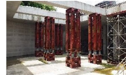
支保工の状況
