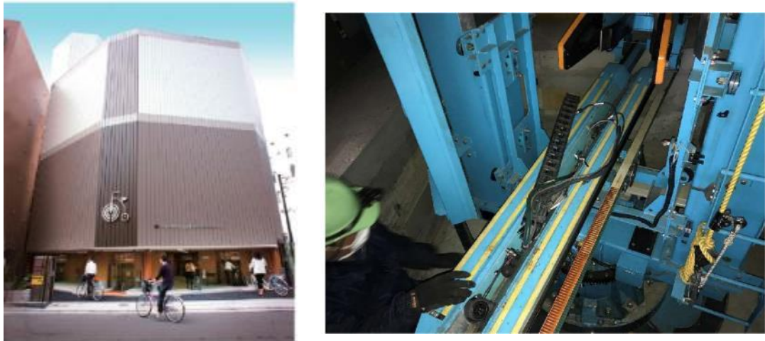
図 2-39 機械式駐輪場及び維持管理状況
