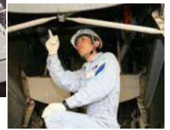
【ソフト面の対策例】 整備・点検の実施
