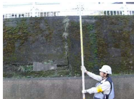
図 5.5 詳細点検実施状況(二ヶ領本川)
