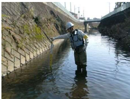
図 5.4 詳細点検実施状況(平瀬川)
