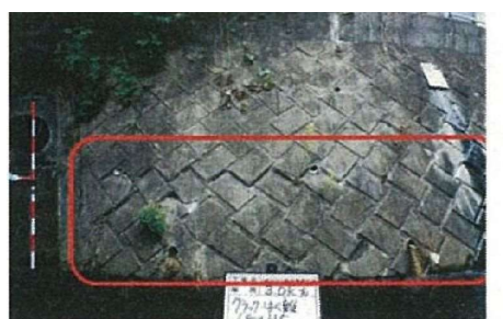
図 6.1 護岸のはらみ出し
