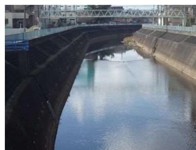
図 14.4 平瀬川(高津区)
