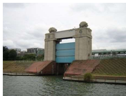
図 14.22 川崎河港水門(川崎区)
