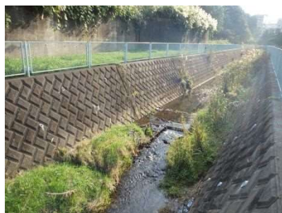
図 14.24 三沢川(麻生区)
