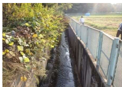
図 14.8 三沢川(麻生区)
