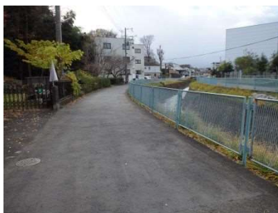
図 14.30 河川管理用通路(宮前区)
