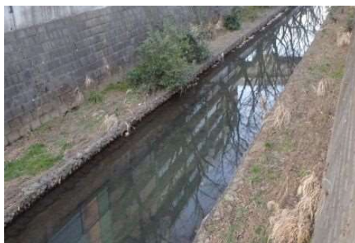
図 6.7 捨石工(麻生川)
