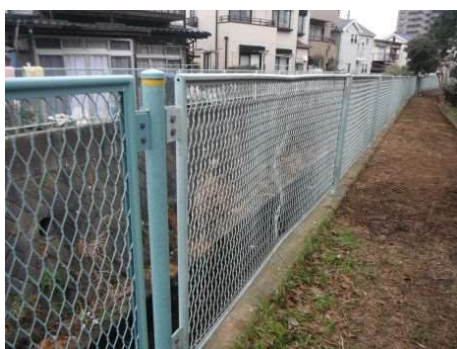
図 6.13 転落防止柵破損状況
