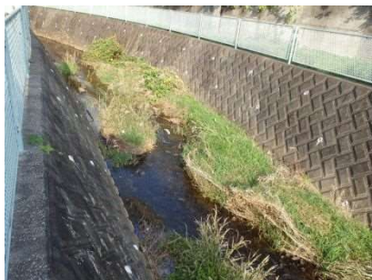
図 14.18 三沢川(麻生区)
