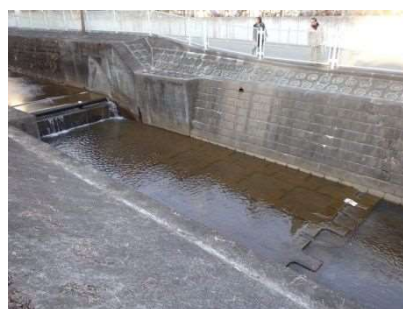
図 14.27 片平川の床止め(麻生区)
