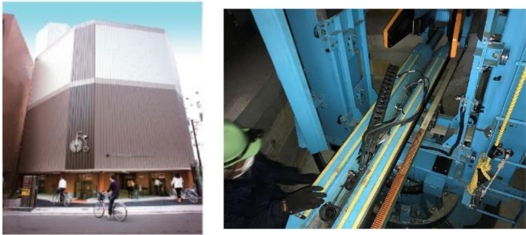
図 2-39 機械式駐輪場及び維持管理状況
