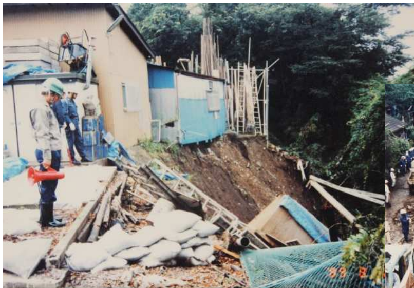
(写真) 平成元年蟹ヶ谷崖崩れ災害
