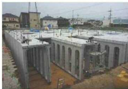
<貯留槽(地下に施工)>
