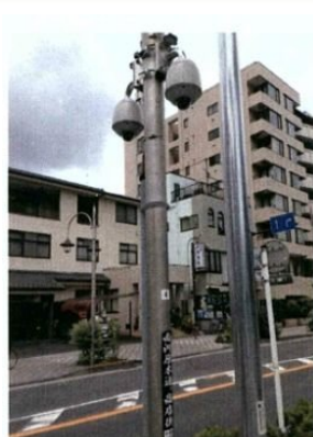
防犯カメラの設置
