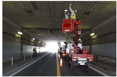
道路施設点検の状況
