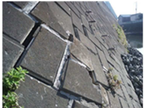
護岸変化の状況
