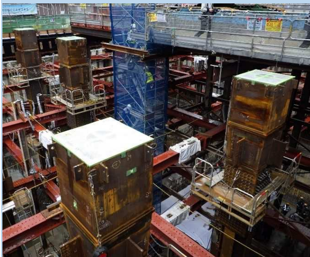
(4) 地下鉄骨工事 (R3年7月～8月)
