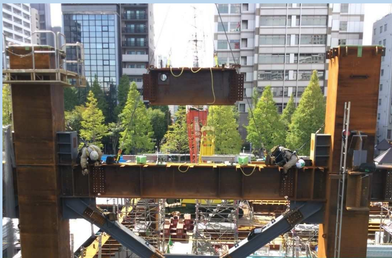
(5) 地下躯体、低層部鉄骨・躯体工事 (R3年8月～)
