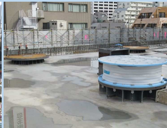
(6) 免震装置設置工事・高層部鉄骨・躯体工事 (R3年11月～)
