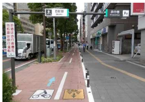
自転車通行環境の整備（川崎区新川通り）
