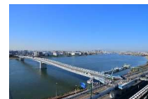
多摩川スカイブリッジ
