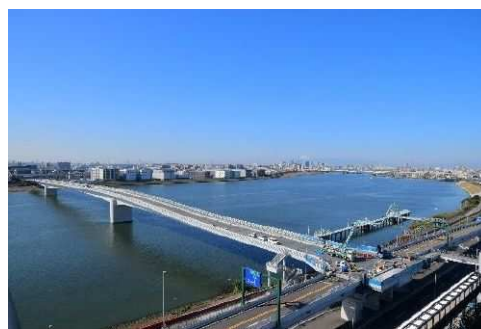
多摩川スカイブリッジ
