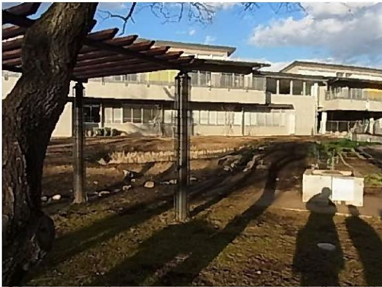
正門側から見た低層2階建ての校舎外観とピオトープ
