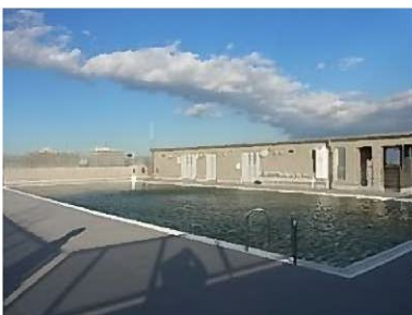
特別教室棟屋根のPV設備
