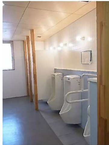
内装木質化の図られたトイレ
