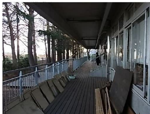
特別教室群バックヤード側の半屋外バルコニー
