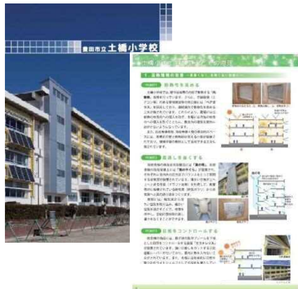
図 3-5 土橋小学校エコ改修資料 (豊田市立土橋小学校)
