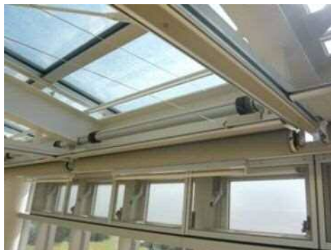
図 3-4 自然換気窓 (杉並区立天沼小学校)
