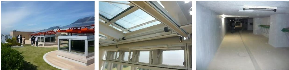
風の塔、スィンドウ、クールヒートトレンチによる暖冷房負荷の低減
