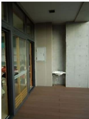
流しが設置されたバルコニー
