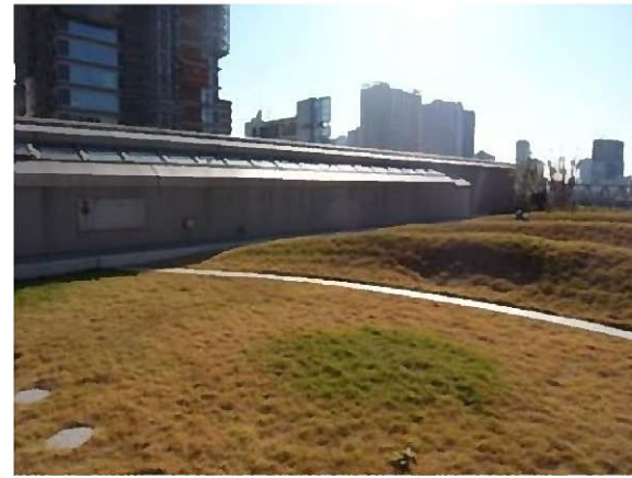
屋上面の芝生広場、全自動散水
