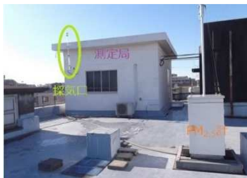
大師分室屋上に設置された大師一般環境大気測定局
