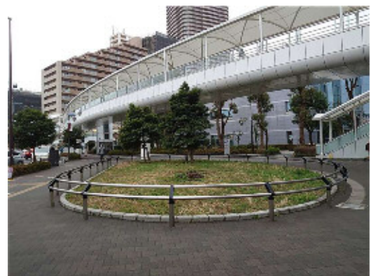
鹿島田駅前交通広場
