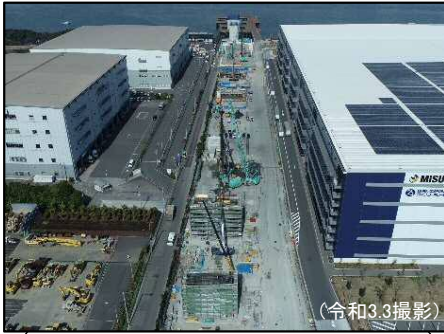
② 東扇島AP部5工区 橋脚下部施工状況
