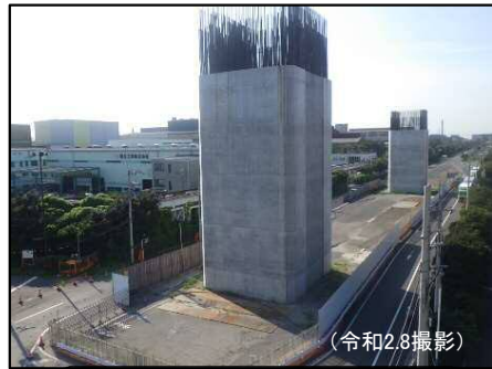
③ 橋脚MP5,6 (令和2.9施工完了) 橋脚下部完成
