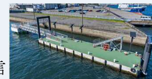
東扇島防災浮桟橋
