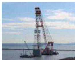
ケーソン据付工事 Caisson installation work 沉箱的安装施工
