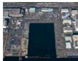
東扇島堀込部 (R3年1月撮影) Excavated part of Higashi-Ogishima (Photo taken in Jan. 2021) 东扇岛堀込部 (摄于2021年1月)
