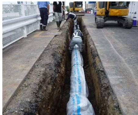
◆大口径管路：口径1,000mmの更新(パイプ・イン・パイプ工法)
