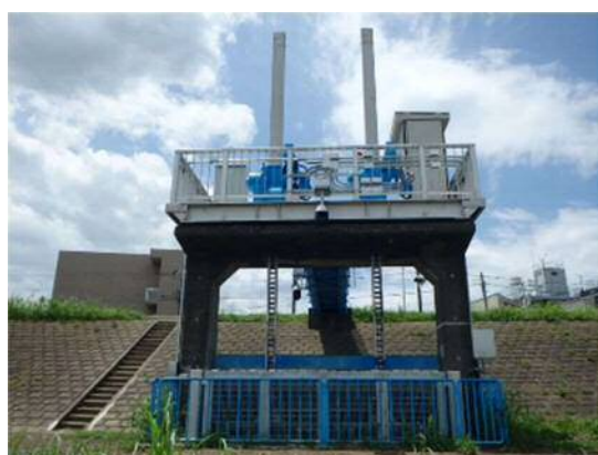
排水樋管ゲートの電動化(令和2(2020)年 7 月稼働)
