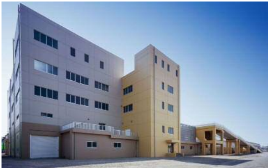
入江崎水処理センター西系施設
