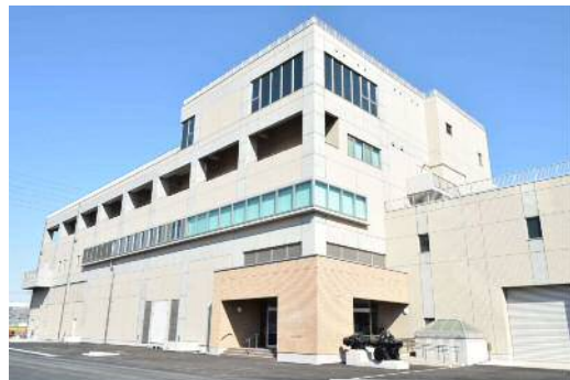
入江崎水処理センター沈砂池管理棟
