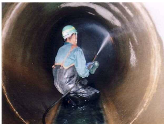
管きよの清掃状況
