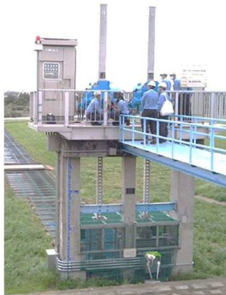
排水樋管ゲート操作訓練
