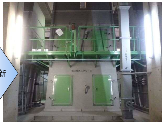
老朽化したスクリーン設備の更新
