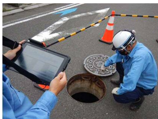
タブレットを用いた管きよの点検状況
