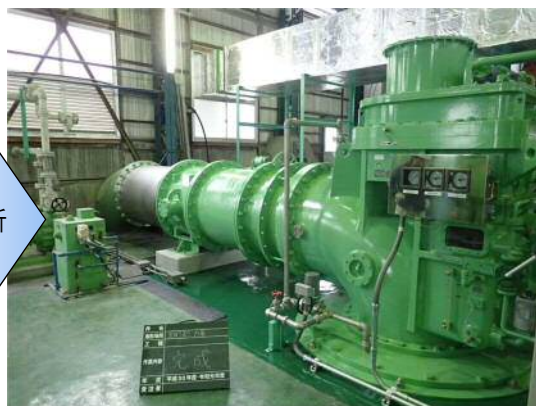
老朽化したポンプ設備の更新
