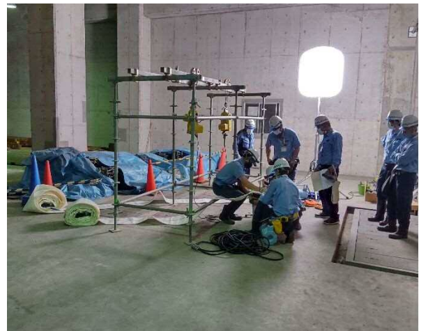
排水ポンプ設置研修
