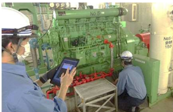
タブレットを用いた設備の点検状況
