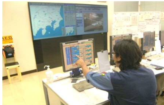
中央監視制御装置による施設の運転
