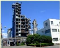
使用済みプラスチックからアンモニア製造用合成ガスを製造
