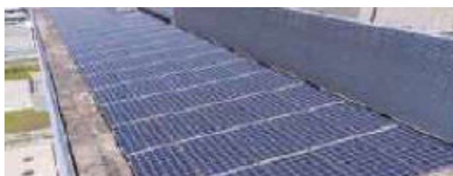
入江崎水処理センター 沈砂池管理棟屋上部
