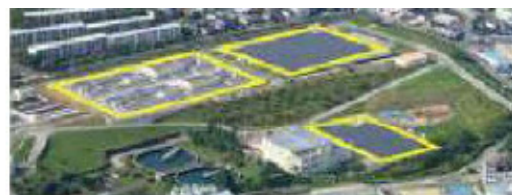
長沢浄水場太陽光発電設備
