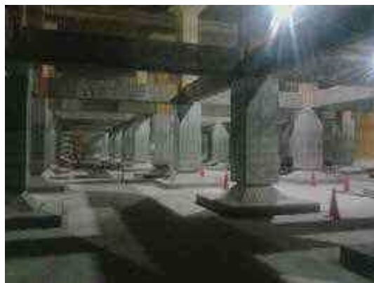
配水池の耐震補強状況
