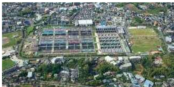
川崎市へ水道用水を供給する西長沢浄水場
