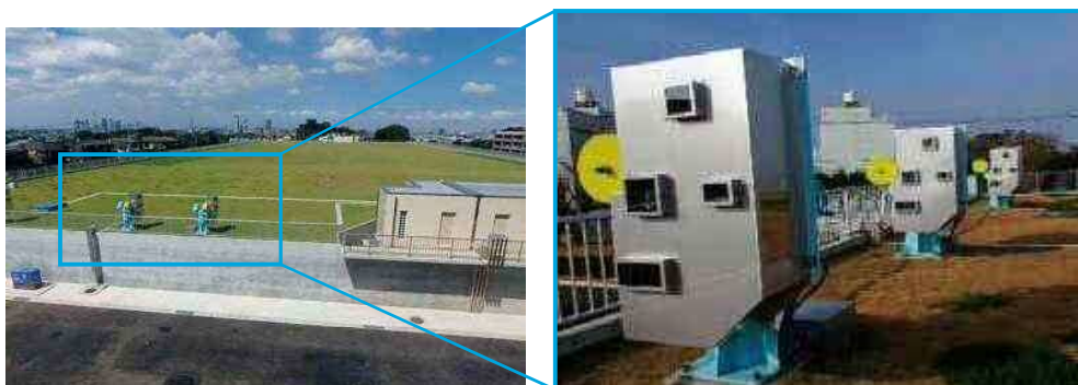
末吉配水池に整備された緊急遮断弁
