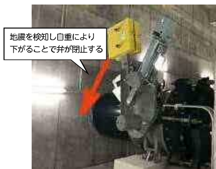
緊急遮断弁(自重式)
