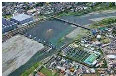
酒匂川から取水する飯泉取水堰
