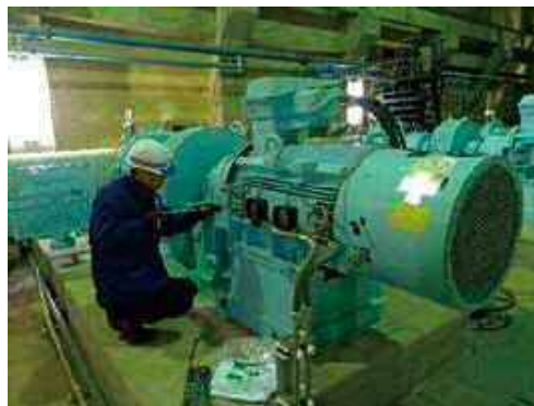
施設の点検(ポンプ定期点検)
