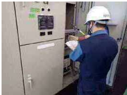
施設の点検(電気設備定期点検)
