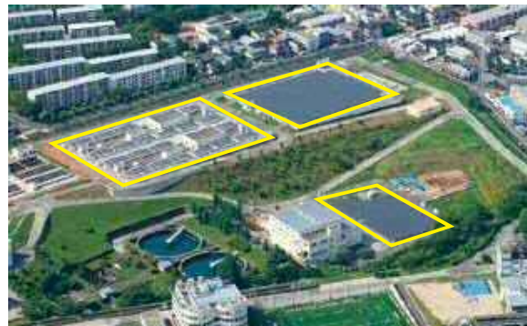
長沢浄水場太陽光発電設備
