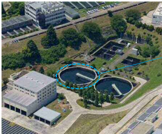
長沢浄水場 排水処理施設 (水道・工業用水道施設)
