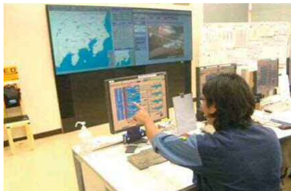
中央監視制御装置による施設の運転
