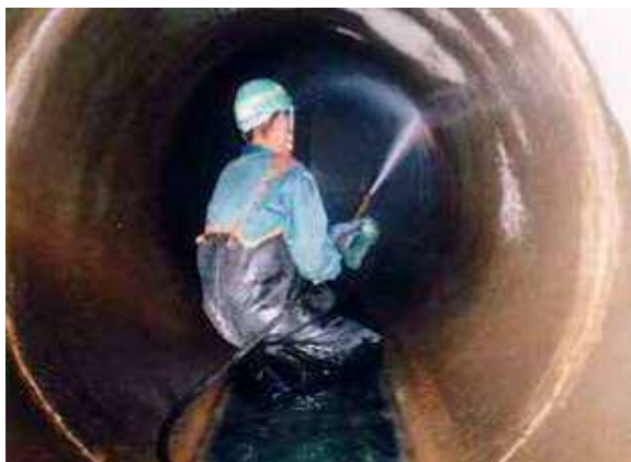
管きよの清掃状況
