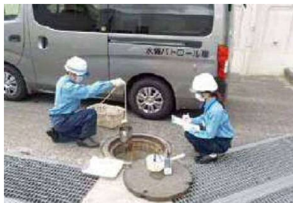
事業場排水採水状況
