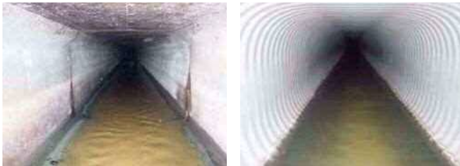
重要な管きよの耐震化(左:耐震化前、右:耐震化後)
