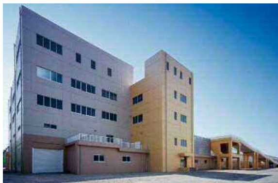
入江崎水処理センター西系施設
