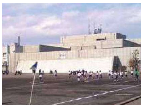
加瀬水処理センター (加瀬ふれあいの広場)
