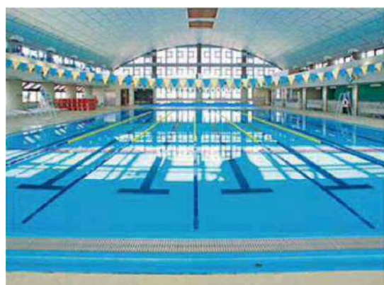
入江崎余熱利用プール
