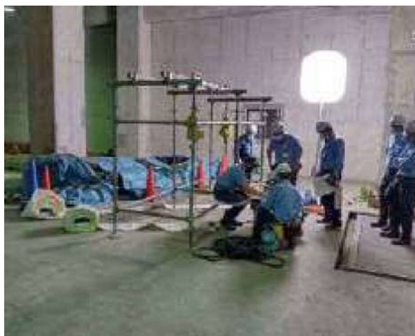
排水ポンプ設置研修
