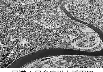
国道1号多摩川大橋周辺
