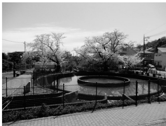
国登録有形文化財(建造物)二ヶ領用水久地円筒分水
