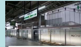
JR武蔵溝ノ口駅に設置したH 2 One™
