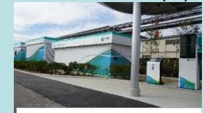
太陽日酸川崎水江事業所の燃料電池フォークリフト用水素ステーション
