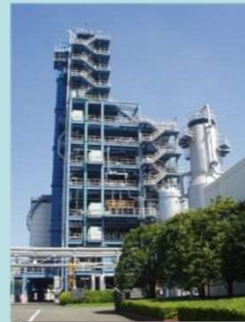
昭和電工川崎事業所 (水素製造プラント)
