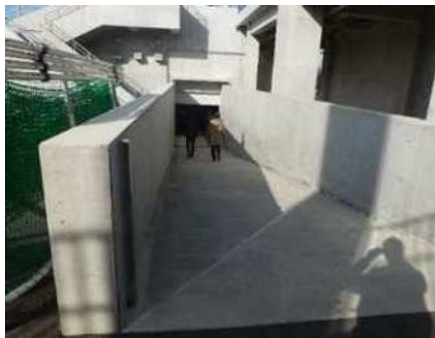
写真5 (搬出入口スロープ)
