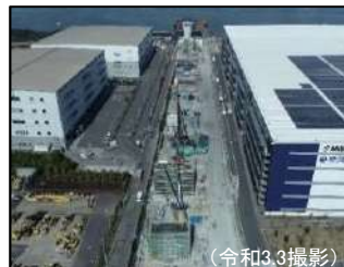
② 東扇島AP部5工区 橋脚下部施工状況
