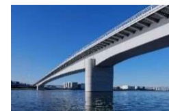
多摩川スカイブリッジ
