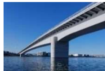
多摩川スカイブリッジ
