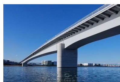
多摩川スカイブリッジ
