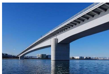
多摩川スカイブリッジ
