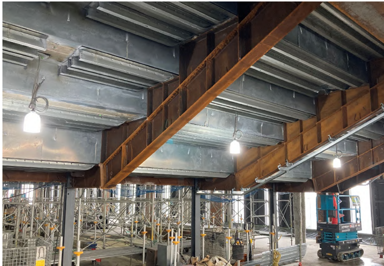
23階議場傍聴席下部空間工事状況(令和4年10月初旬)
