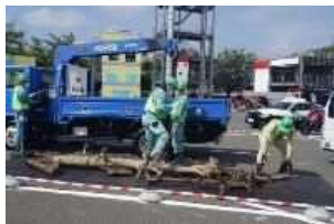
道路啓開（川崎建設業協会）
