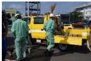
道路啓開（道路公園センター）
