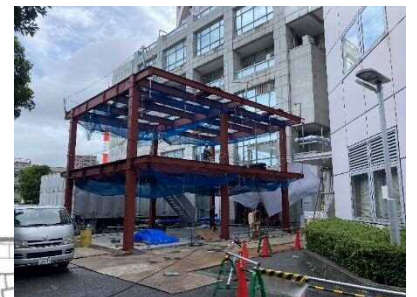
給水ポンプ棟建設予定地の現況 (8月12日現在)
