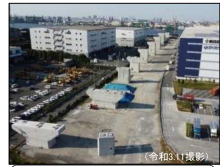
② 東扇島AP部SP10～17,P2R (令和3年11月施工完了) 橋脚工完成
