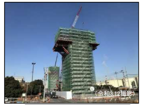
③ 橋脚MP5,6 橋脚工施工状況
