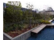
屋上緑化の様子
