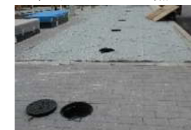
マンホールトイレ
