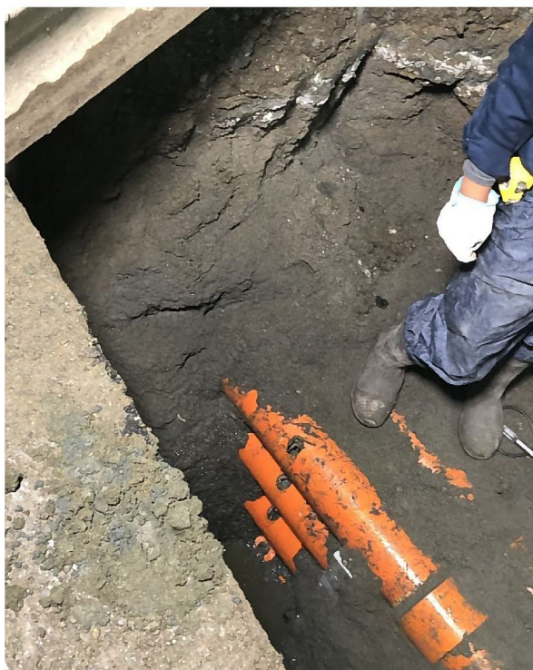
写真：東京電力地中送電線破損状況
